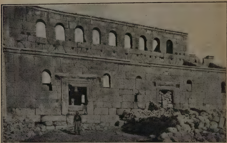
Fig. 5. — Église de Mchabbak. Extérieur (d'après Butler).
